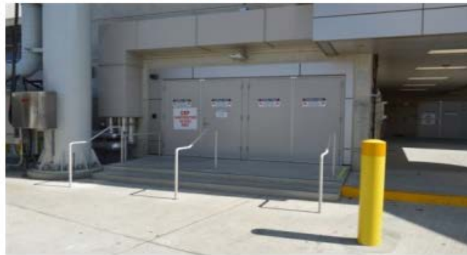
Gate 148 Ramp Double Door
